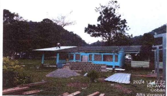
Foto 4: inicio de la sustitución de láminas de la cocina
