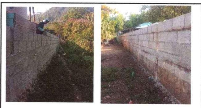
Foto 4: colocacion de block en muro perimetral.
