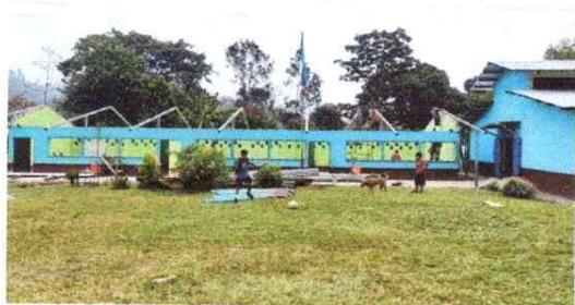
**Foto 3: finalización de la instalación de las tijeras de las aulas.**
